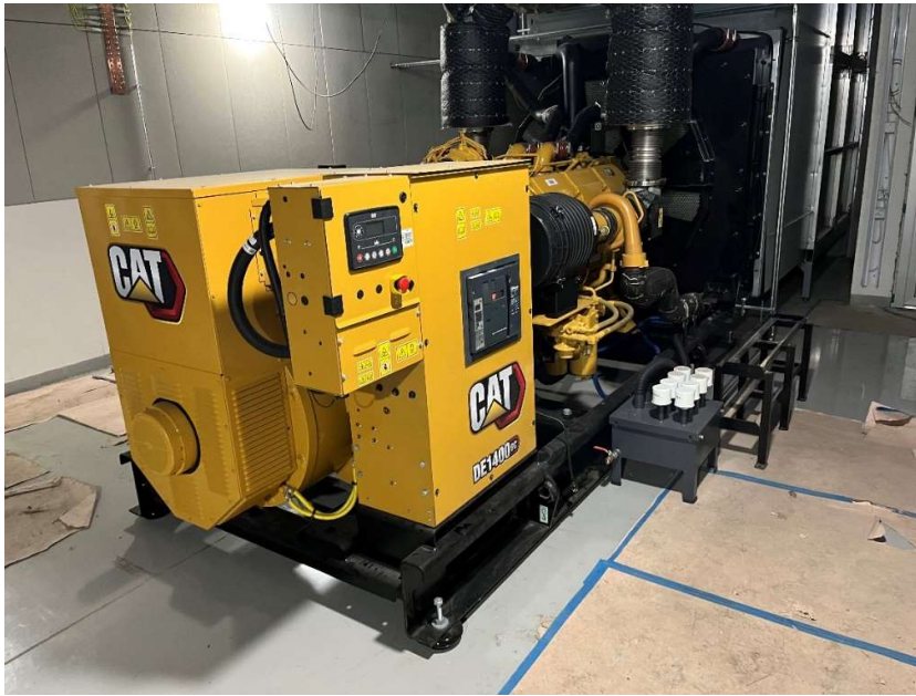
Kuva 5. Varavoimakone asennettuna paikalleen . (Kuva: Petri Ylönen)
