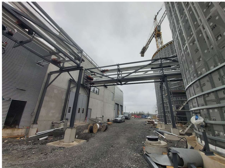
Kuva 4. Putkisilta-asennuksia. (Kuva: Veli-Matti Hatvala)
