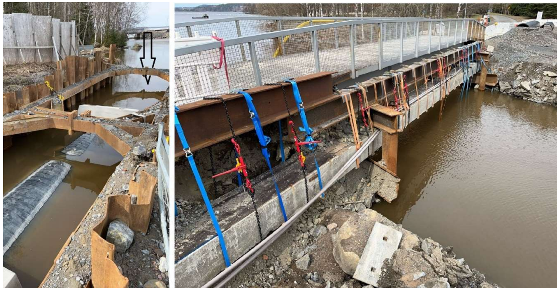
Kuva 11. Vasen kuva PK3 kuilulta rantaan tehdystä tuetusta kaivannosta, jossa nuolella osoitetussa kohdassa yhdistetään laipalla ensimmäinen putkiletka. Oikea kuva on kannaksen kohdalta, jossa 110 kV sähkökaapeli on tuettuna ja klv-silta. Ensimmäinen putkiletka alittaa kannaksen sillan kohdalta. (kuvat Henri Luchtala / Sitowise Oy).
