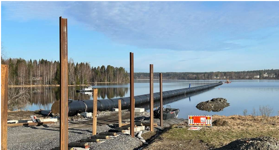
Kuva 13. Putkiletka odottaa siirtoa Sankilasta Vihilahteen (kuva: Ari-Matti Ilkka)
