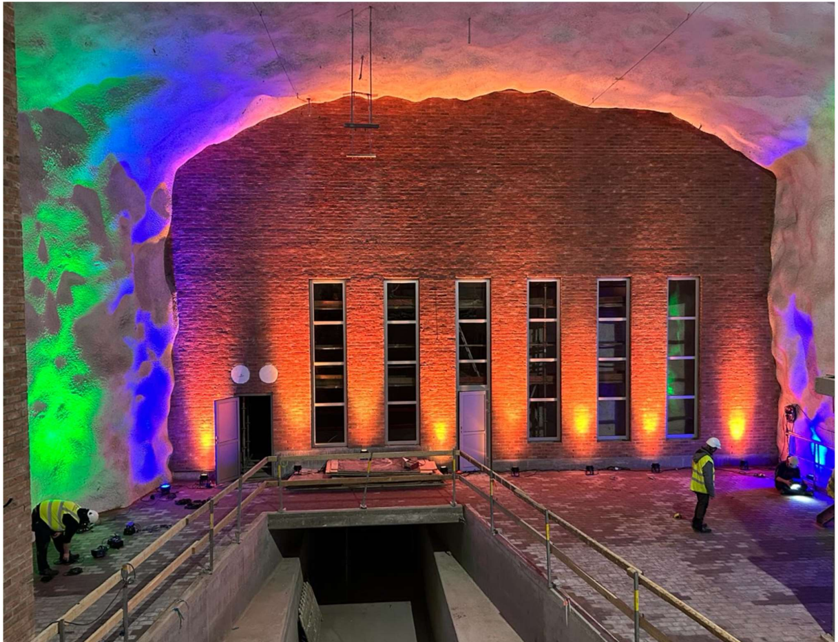
Kuva 1. Keskuspuhdistamossa on oma maan alle rakennettu Tammerkoski. Tästä kohtaa puhdistettu jätevesi johdetaan purkuviemäritunneliin ja edelleen Vihilahteen purkutupkeen. (Kuva: Henri Hakala)
