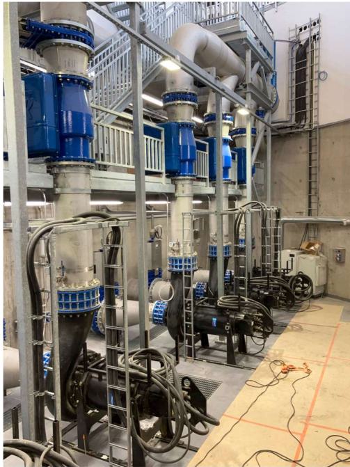
Kuva 16. Vasemmalla pumppuja Viinikanlahden pumppaamon pumppusalissa ja oikealla pumppusalin pohjalle johtavat, 10 metriä korkeat, kierreportaat työmaavalaistuksessa (Kuvat: Pauli Lahtinen, Ramboll CM).
