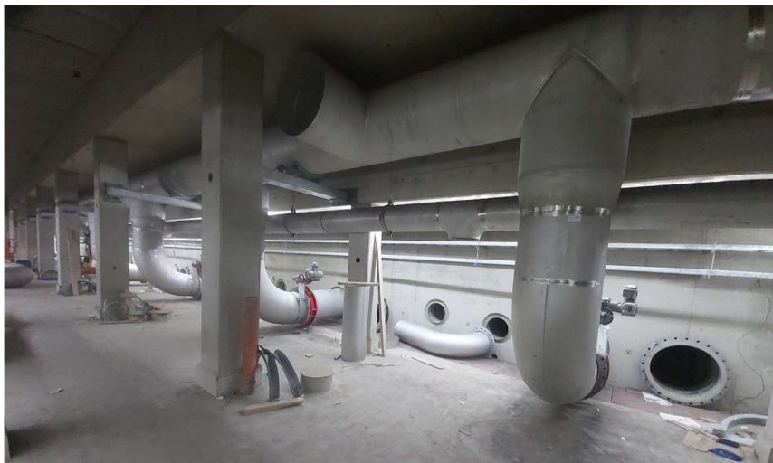
Kuva 2. Hiekkasuodatuksen etuputkiston asennustyöt käynnissä. (Kuva: Veli-Matti Hatvala)
