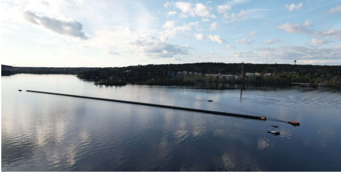
Kuva 14. Putkiletkaa siirretään Sankilasta Vihilahteen (kuva: Timo Rajakallio / Creative Ky)
