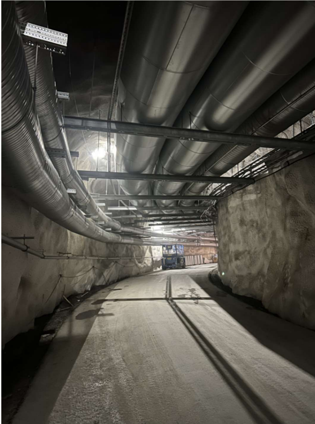
Kuva 8. Huoltorampin putkisto- ja kanava-asennuksia. (Kuva: Henri Hakala)
